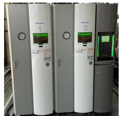
LPガスボイラー
